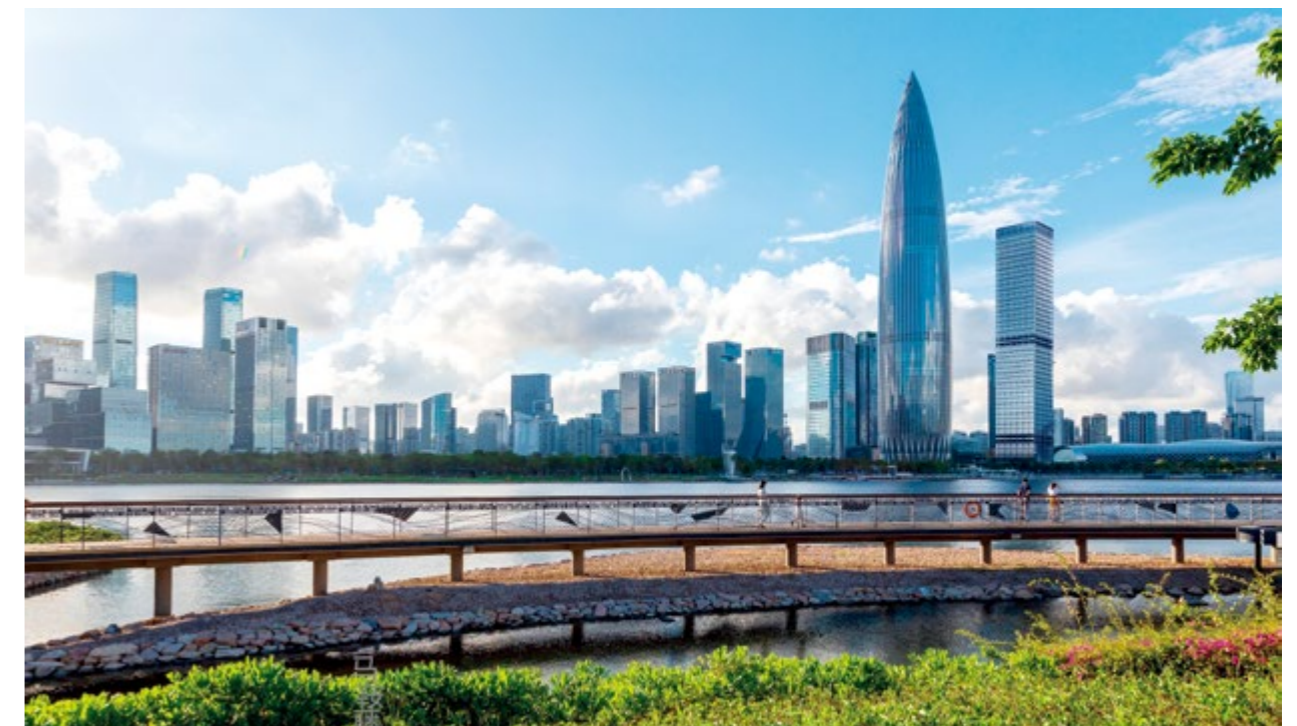
▲ 2018 年新投用的华润内地总部大楼—中国华润大厦，在设计、建造过程中秉持低碳环保策略，应用多项先进绿色环保技术，采用环保材料，获得了包括美国 LEED 绿色建筑认证在内的多项权威认证。
