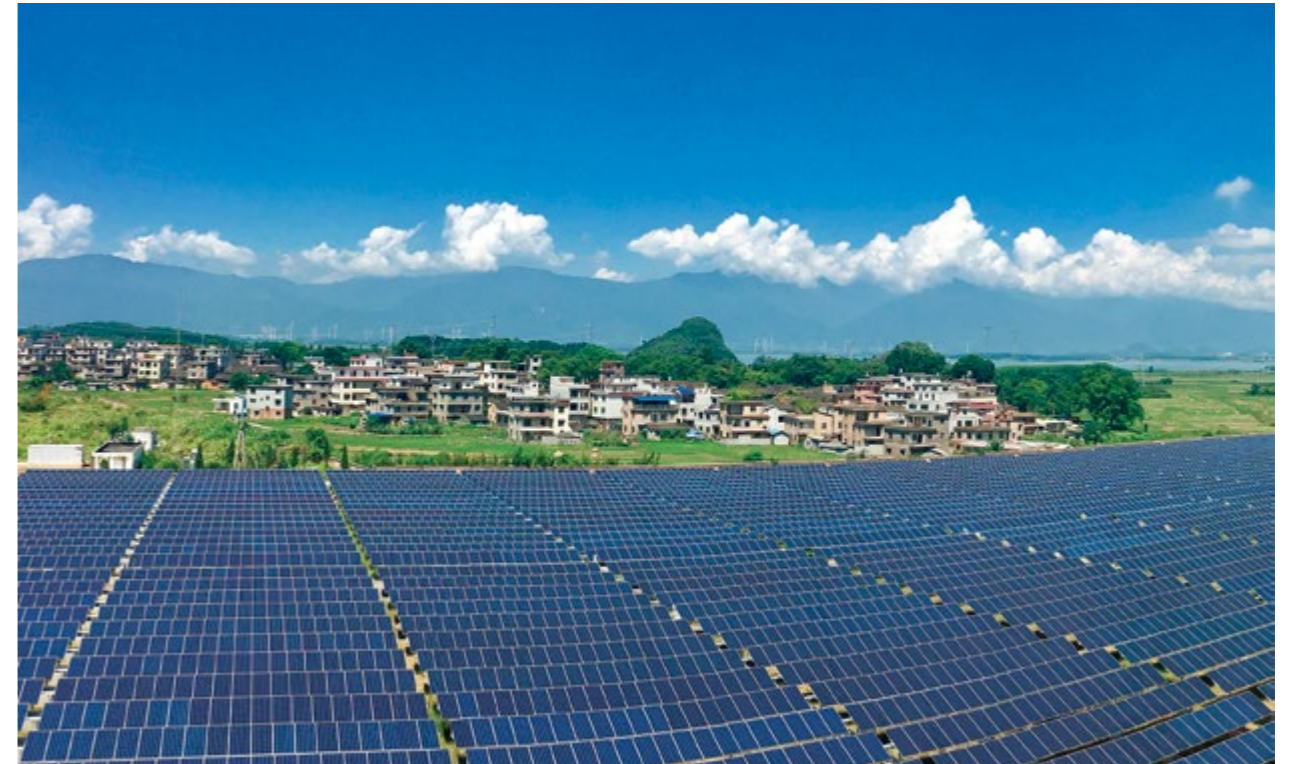
广西贺州华润循环经济产业示范区 6MW 太阳能光伏发电项目是华润电力在桂投资兴建的首个太阳能光伏发电项目，投资约 4400 万，建成后每年可为地区电网贡献 6000MWh 清洁电能，是示范区打造风、光、火多能互补综合能源供应基地的重要组成部分。
