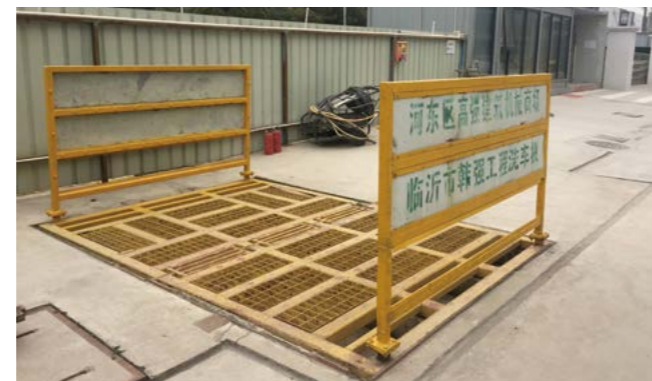
施工用水循环利用
