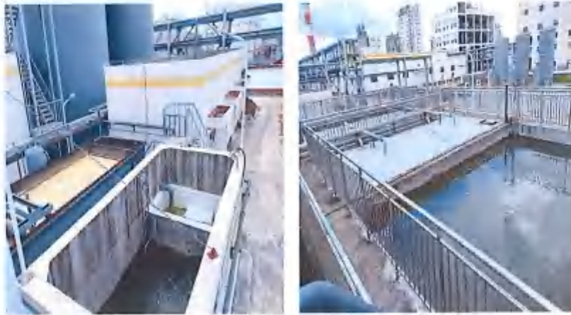
图4-3 项目自建污水处理站现场图
